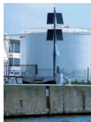
Antennes met zonnepanelen langs het kanaal
